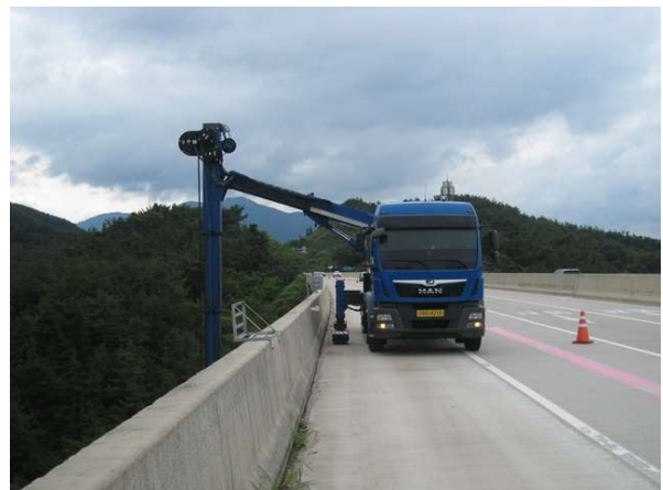
굴절점검차를 이용한 근접조사
